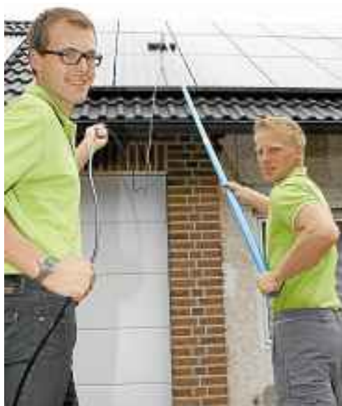
Durch regelmäßige Reinigung bleiben Photovoltaik-Anlagen leistungsstark.
